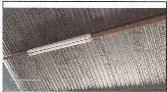
Foto 4: Sustitución de focos LED
