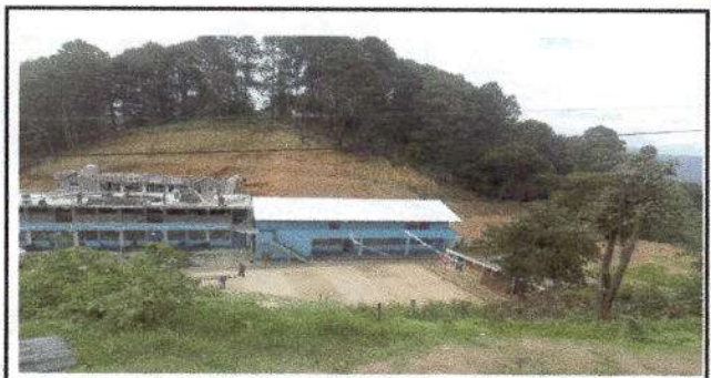
Foto 6: Sustitución de lamina troquelada aluzinc caibre 28
