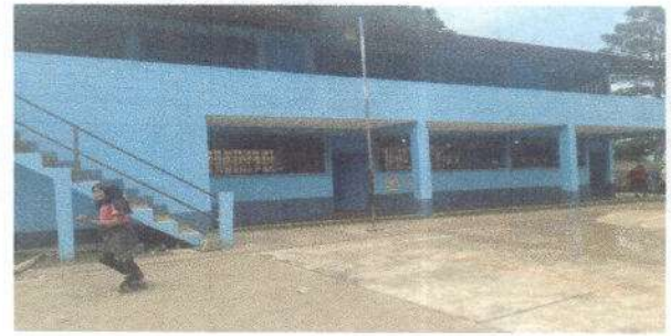
Foto 2: Pintura en muros exteriores e interiores
